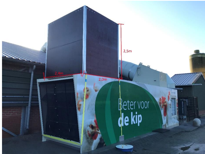
Figuur 17: Houten constructie voorzien op unit 2 en 3.
