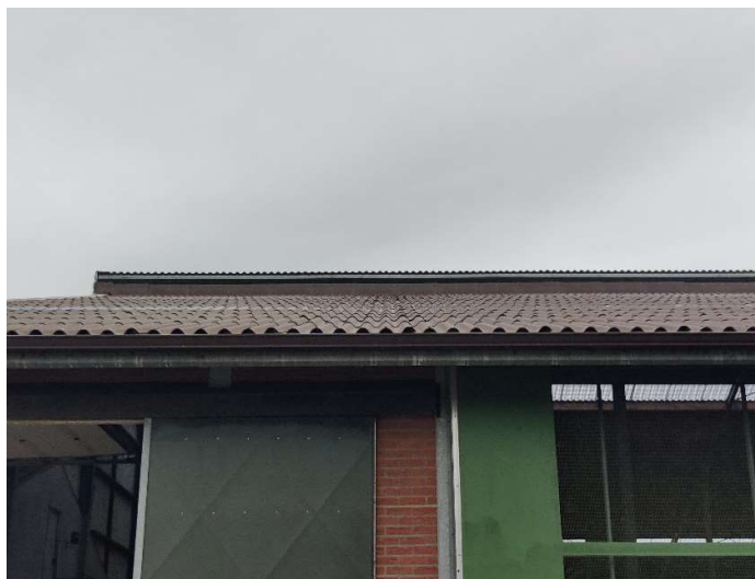
Figuur 5: Oversteeknok van stal B2.
