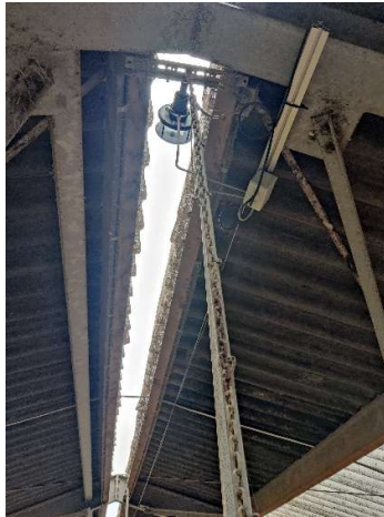
Figuur 8: Nok met opstaande wanden van stal B3.
