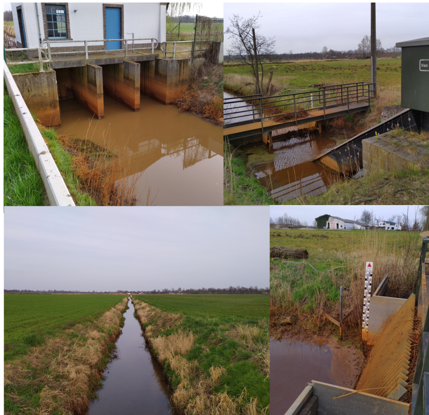
Figuur 38: Overzichtsbeelden van landbouwland, centraal pomphuis, vijzelpomp en waterpeilmeting aan de vijzelpomp.
