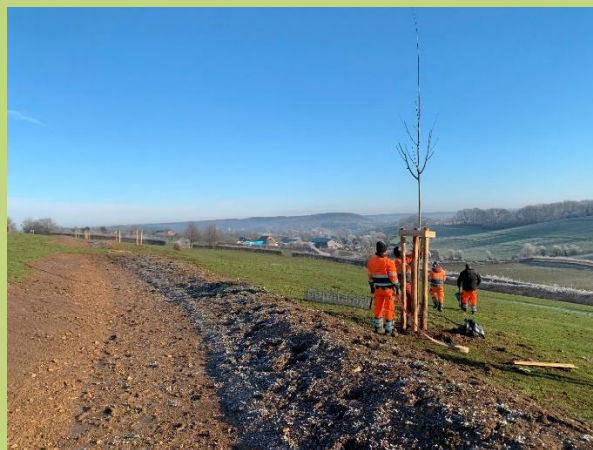
Figuur 4. Links: aanleg van de swales in Voeren m.b.v. een laser en kleine kraan. Rechts: beplanting van de swales met fruitbomen © Christel Cornelissen RLHV
