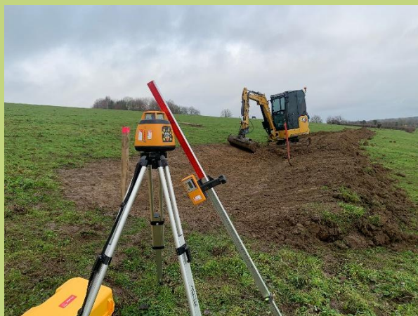
Figuur 4. Links: aanleg van de swales in Voeren m.b.v. een laser en kleine kraan. Rechts: beplanting van de swales met fruitbomen © Christel Cornelissen RLHV
